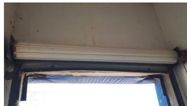
Puerta de carga, con cortina y plástico para evitar fuga de aire frío
