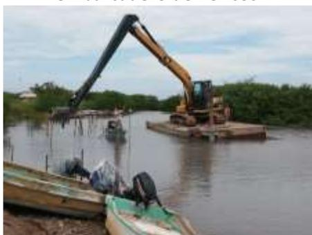
**Plataforma flotante de apoyo para la maquinaria utilizada para el desazolve del canal.**
