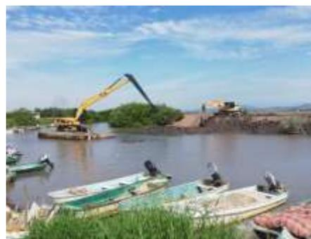
**Se aprecia la zona de tiro del material, reforzando el bordo perimetral del canal.**
